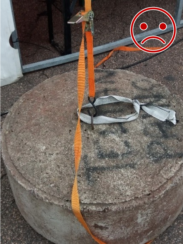
Kuva 7 EI NÄIN. S-koukku ei ole lukittava. Koukku irtoaa rakenteen liikkessa.
