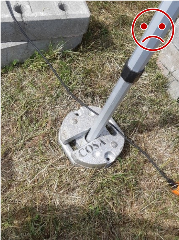
Kuva 1 EI NÄIN. Painojen lukitus toisiinsa puuttuu. Painot irtoavat painovoimaisesti, eivätkä pysy tolpan ympärillä tuulen ravistellessa teltaa.
