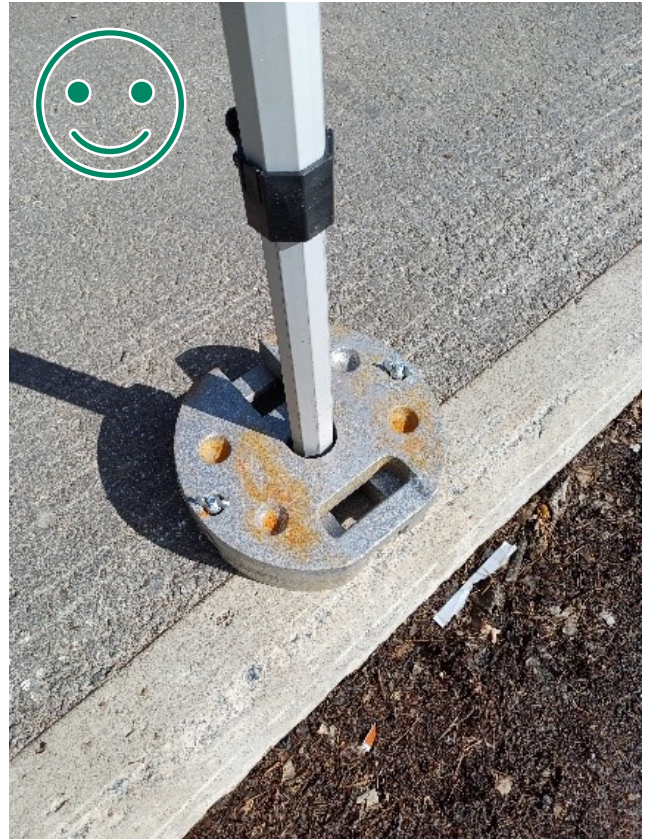
Kuva 2 HYVÄ TAPA. Molemmat painot kiinnitetty siipimutterilla molemmin puolin. Hevosenkämpäpainot vastakkain, jolloin tolppa ei pääse irtoamaan rakenteen liikuessa. Kulmatolpan maajalan tulee kestää kyseinen paino.
