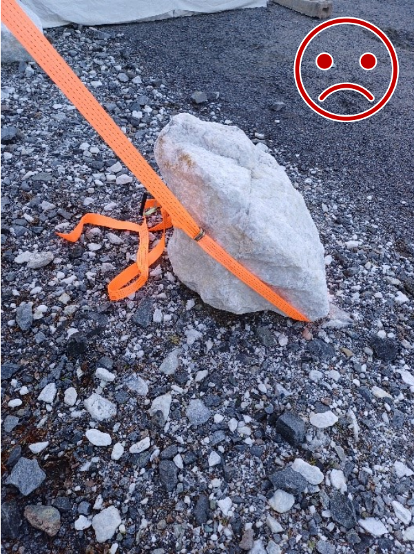
Kuva 5 EI NÄIN. Liinaa ei ole lukittu kiveen ja teräviä reunoja.
